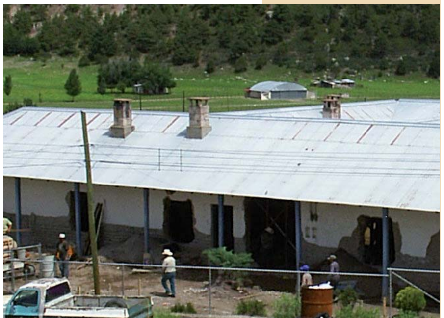
Das Krankenhaus „Hospital de la Tarahumara“ wird neu gebaut.
