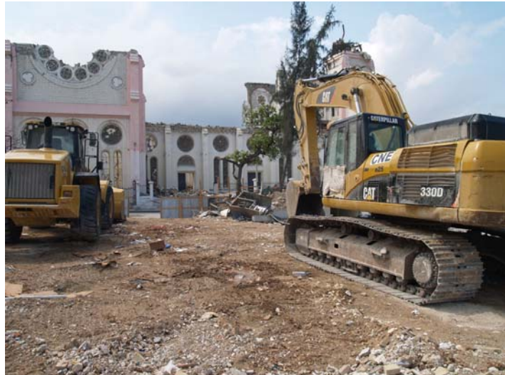
Einige der wenigen Bagger. Im Hintergrund die Kathedrale
